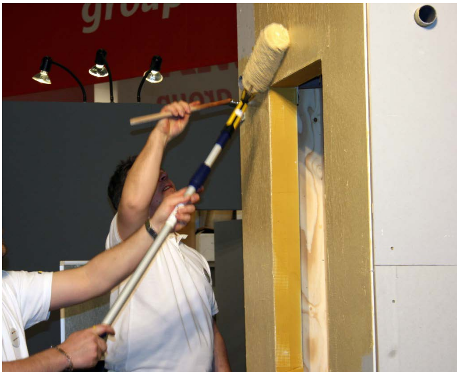
Figur 4. Applicering av rollbart stomskydd.
